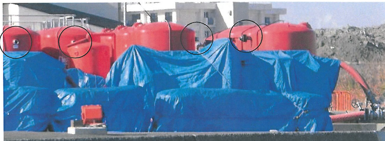
青いタンクはブルーシートで覆われていた(2023年12月10日)
